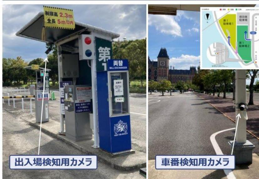
数台のカメラで大型駐車場の混雑状況見える化と車番検知を実現
